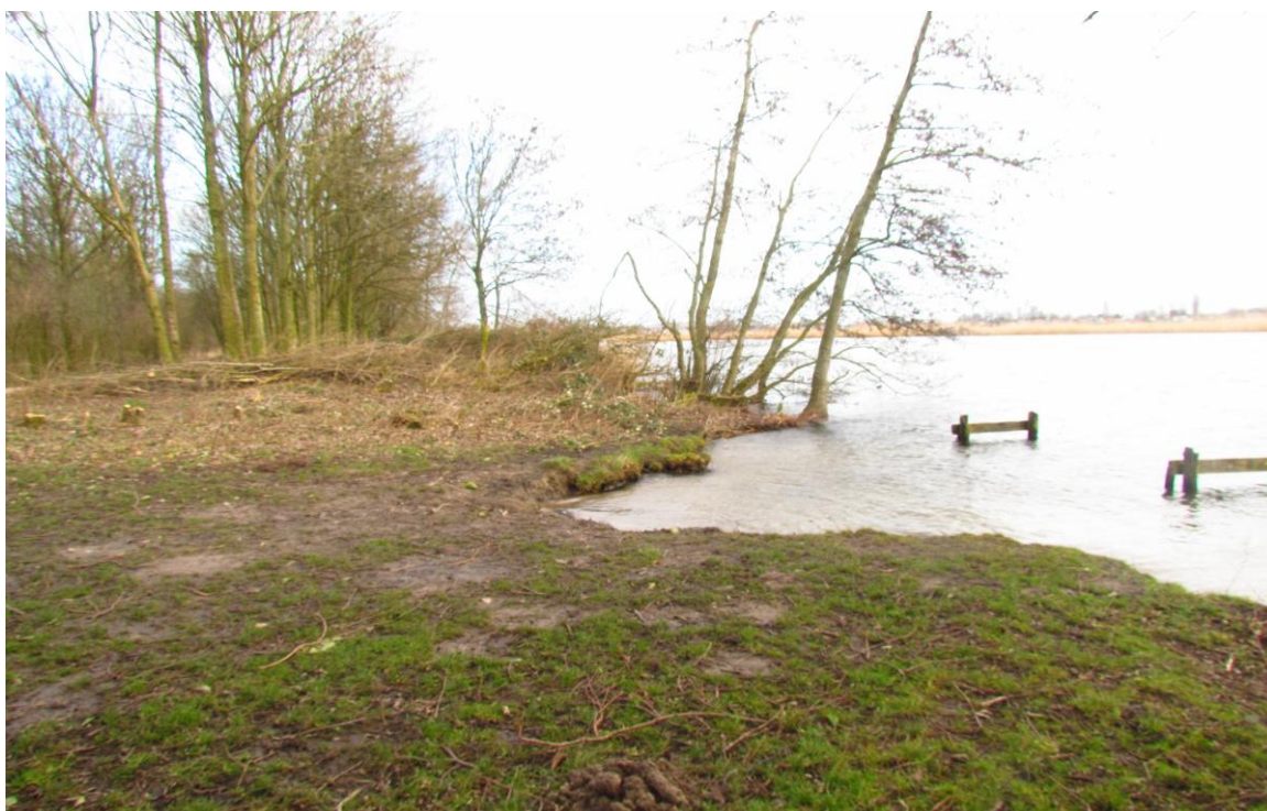
Foto 5: de Elzen midden achter op de foto houden de oever vast. Van de vroegere ( vis?) steiger resteren nog de palen en dwarsbalken. Achter de steiger heeft het water heel wat onbeschermde grond weggespoeld. Dat bomen de oever beschadigen blijkt hier aantoonbaar onjuist, integendeel: ze beschermen de oever en maken de aanleg van beschoeiing overbodig.
